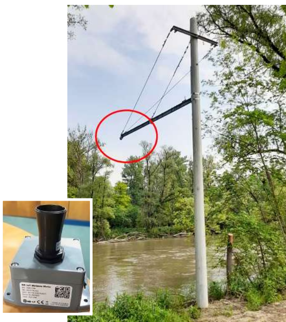
Slika 10: Vodomjer smješten na posebnom nosaču sa NB-IoT uređajem
