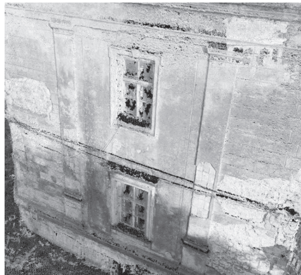
Slika 3: Prikaz progušćenog oblaka točaka fasade Rabatine kule, na sjeverozapadnoj fasadi uličnog pročelja
