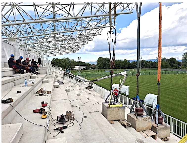
Slika 1: Statičko probno opterećenje nadstrešnice tribine stadiona ŠNK Slavonija betonskim blokovima
