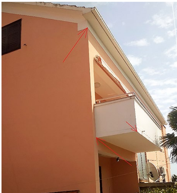
Slika 1: Primjer zgrade koju je potrebno snimiti (izvor: privatna arhiva)
